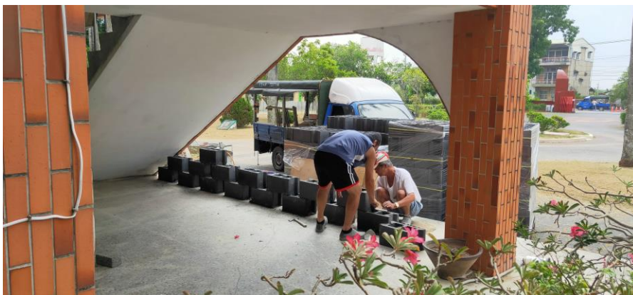
說明：改造中，工人細心的疊起空心磚，並加以固定
