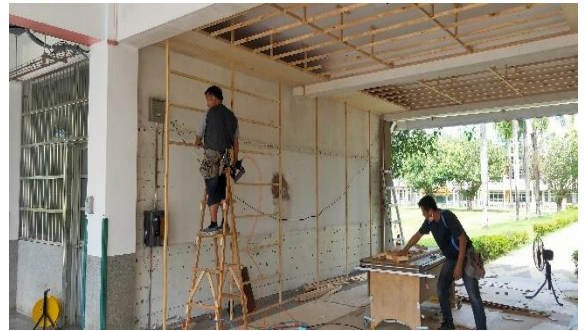
說明：改造中，拆除原有公佈欄重新釘框架
