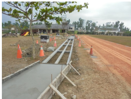
說明：位置地點混凝土澆置
