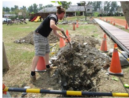
說明：挖設地基
