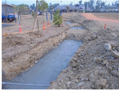
說明：位置地點基礎 RC 工程
