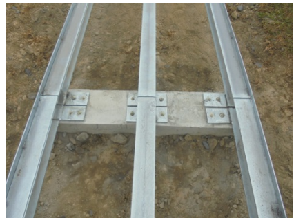
說明：位置地點膨脹螺絲固定
