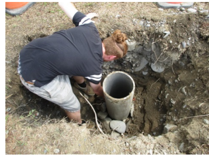
說明：埋設管路
