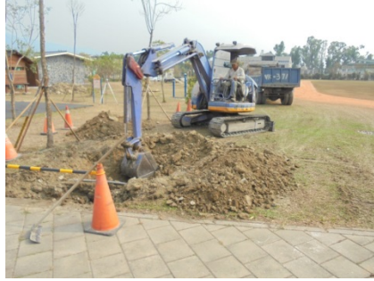
說明：位置地點基礎挖掘
