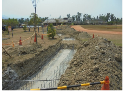
說明：位置地點鋼筋組立
