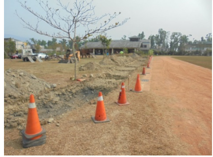
說明：位置地點基礎挖掘
