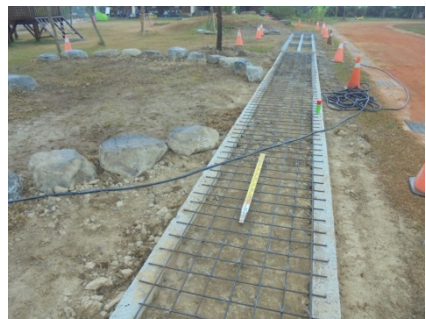
說明：位置地點鋼筋檢查
