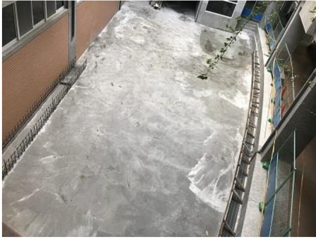
說明：集水台建模、鐵木平台基礎(108.09.19)
