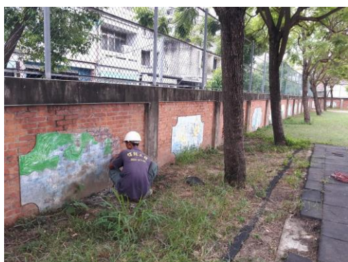
說明：打除紅磚面水泥鋪面
