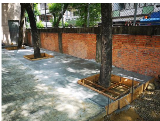
說明：打除紅磚面水泥鋪面
