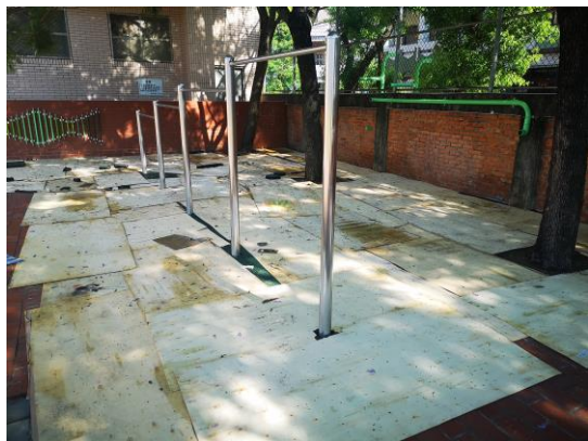
說明：傳聲筒架設與固定
