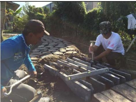
說明：以石板立砌的方式鋪設步道
