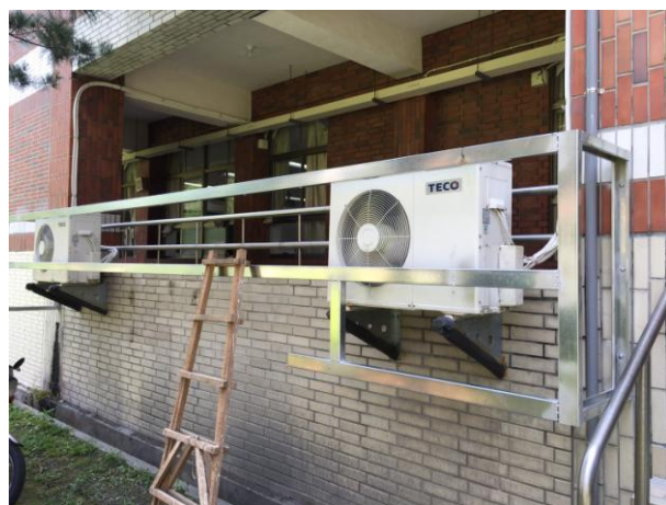
鋼構冷氣格柵
