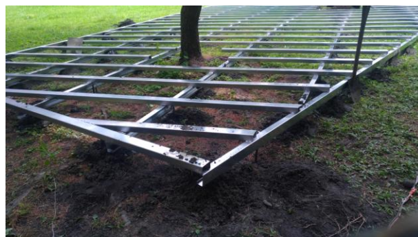
邊角接合處向下挖深 50 公分四根鋼筋綁紮 立柱灌入水泥
