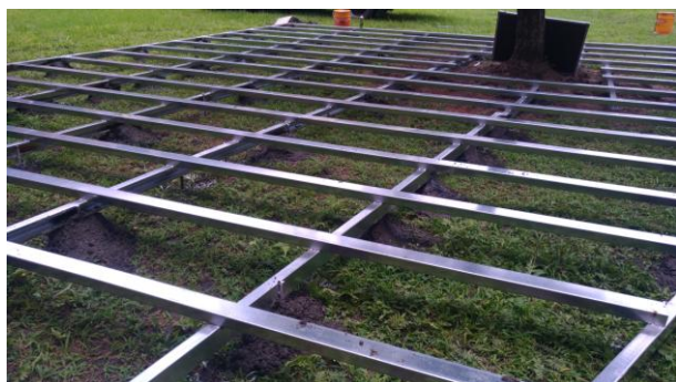
鋼構木平台基座
