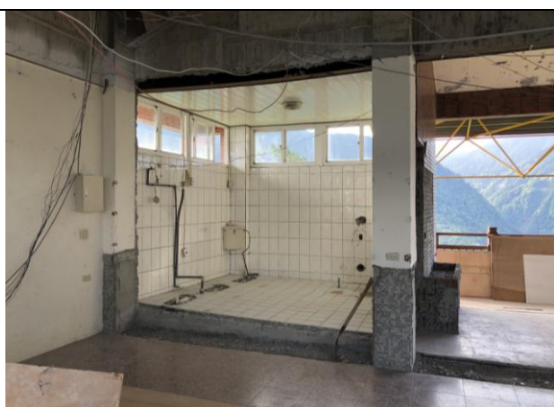
原有廁所改造前
