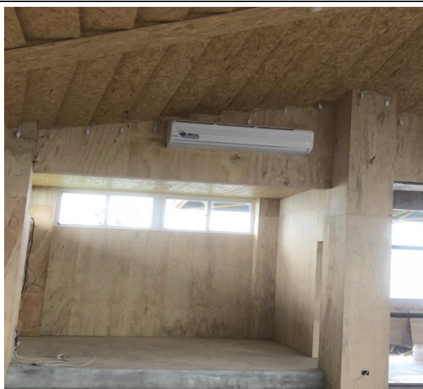
說明：儲藏室施作
