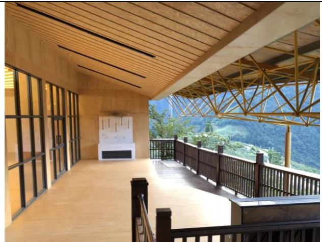
室外施工後(由左後方拍攝)
