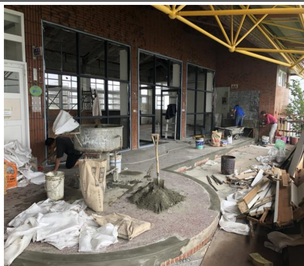
說明：室外平台泥作
