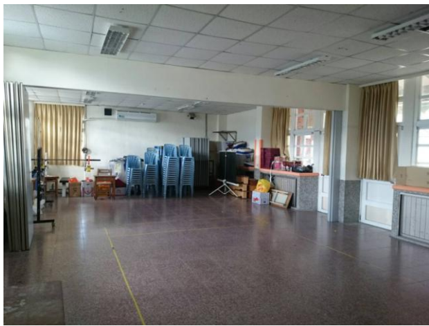
室內施工前 (由左後方拍攝)
