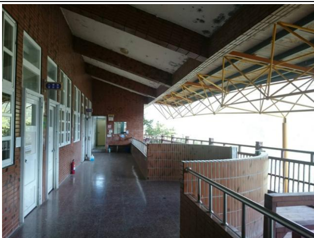
室外施工前(由左後方拍攝)
