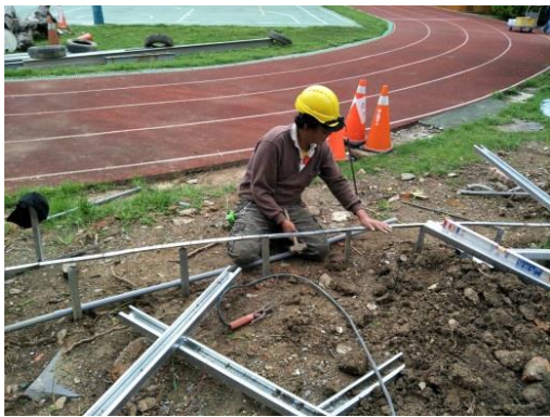
說明：搭建鋼構
