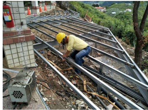
說明：搭建鋼構
