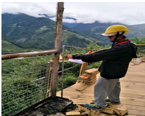
說明：玻璃欄杆搭建
