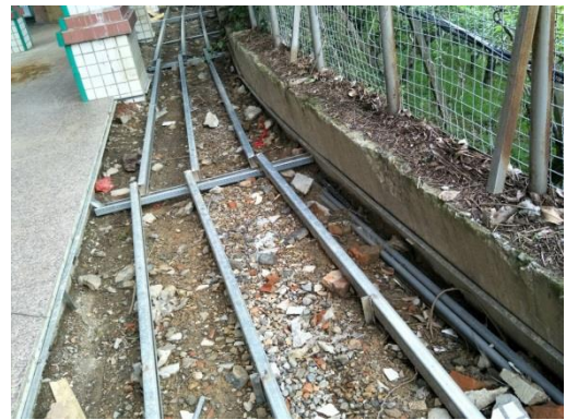
說明：搭建鋼構
