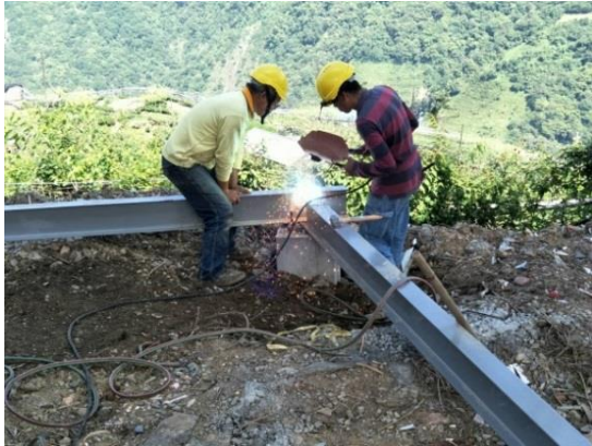
說明：搭建鋼構
