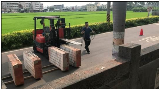
說明：堆高機搬運壁牆板
