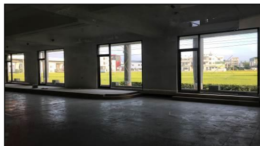
說明：落地鋁門窗安裝完成
