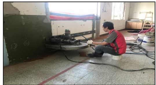
說明：壁牆濕式工法水平切割
