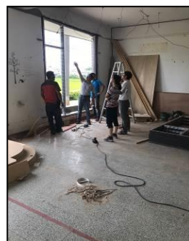
說明：鋁門窗框安裝作業中
