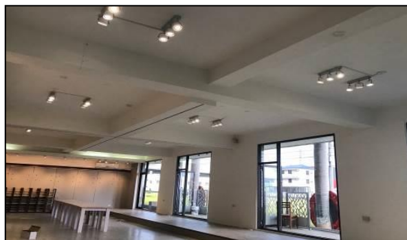
說明：LED 投射燈燈具更新完成
