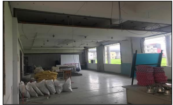
說明：封閉裝潢拆除後空間樣貌
