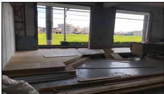
說明：耐磨地板施工
