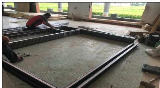
說明：落地鋁門窗現場組裝
