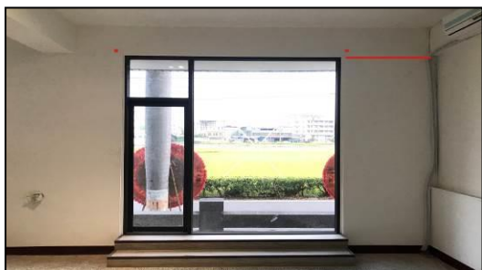
說明：落地鋁門窗安裝完成
