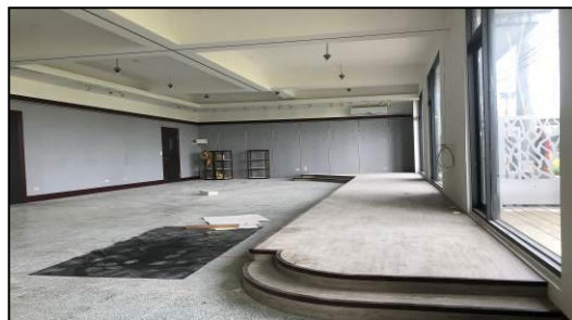
說明：耐磨地板施工完成
