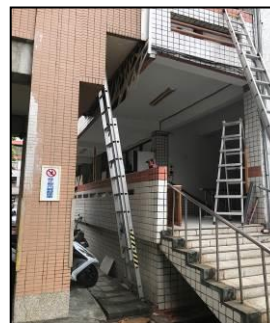
說明：固定框安裝
