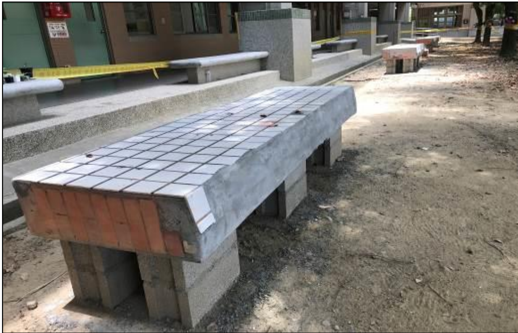
利用切割窗台台度牆面設置校園休憩桌面
