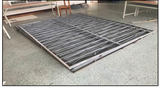
說明：拆卸之鐵窗
