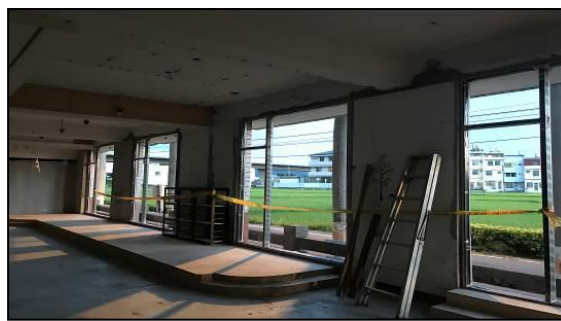
說明：鋁窗框安裝完成
