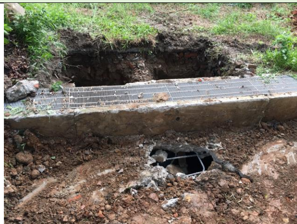
說明：木平台基礎開挖
