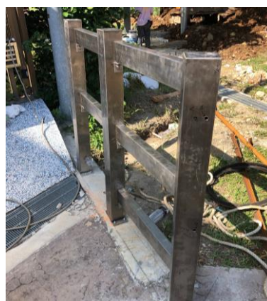
說明：圍籬鋼構組立完成
