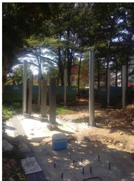
說明：攀爬區及木平台立柱完成
