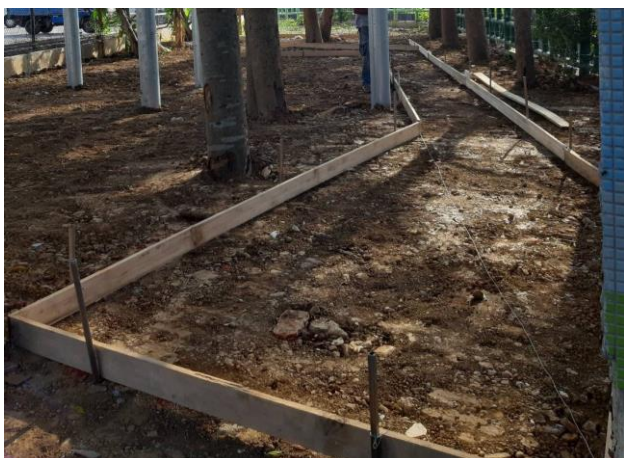
說明：地坪板模施作
