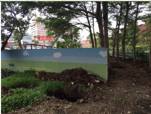
說明：攀爬區基礎開挖
