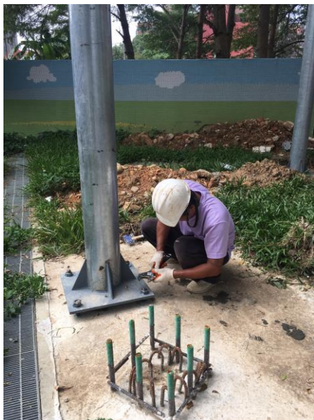
說明：立柱施作
