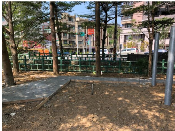
說明：地坪灌漿完成
