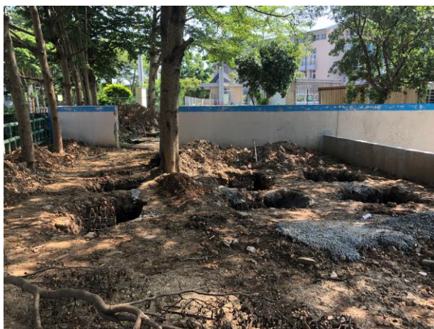
說明：攀爬區基礎鋼筋綁紮
