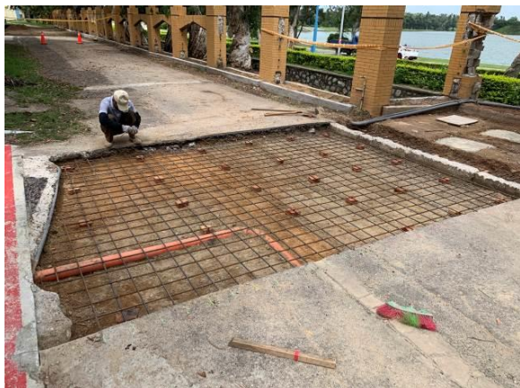
整地、綁鋼筋、基礎灌漿
