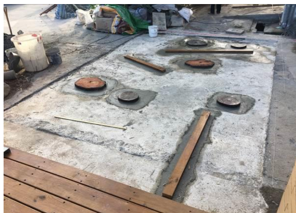
整地、綁鋼筋、基礎灌漿
