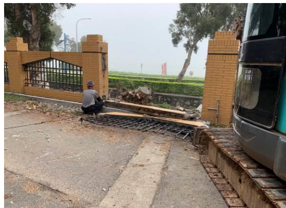
舊圍牆、鐵格柵依設計圖說進行局部拆除
