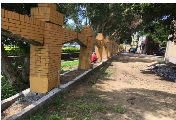
舊柱體結構修復、砌磚、粉光
