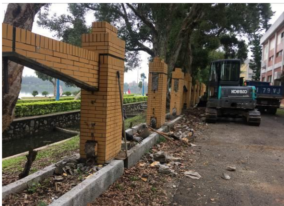
舊圍牆、鐵格柵依設計圖說進行局部拆除
