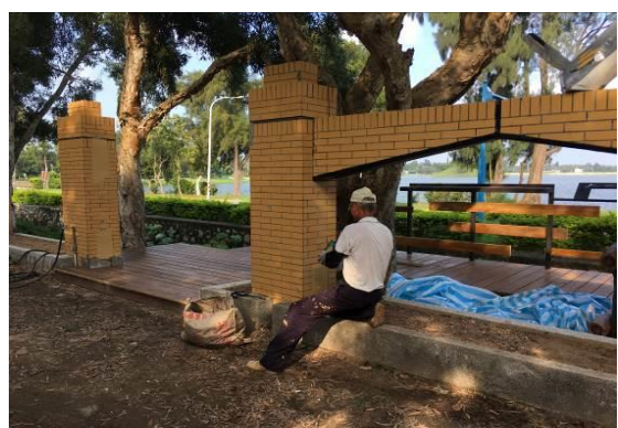
拆除面鑿平後水泥粉光、花台洗石子
