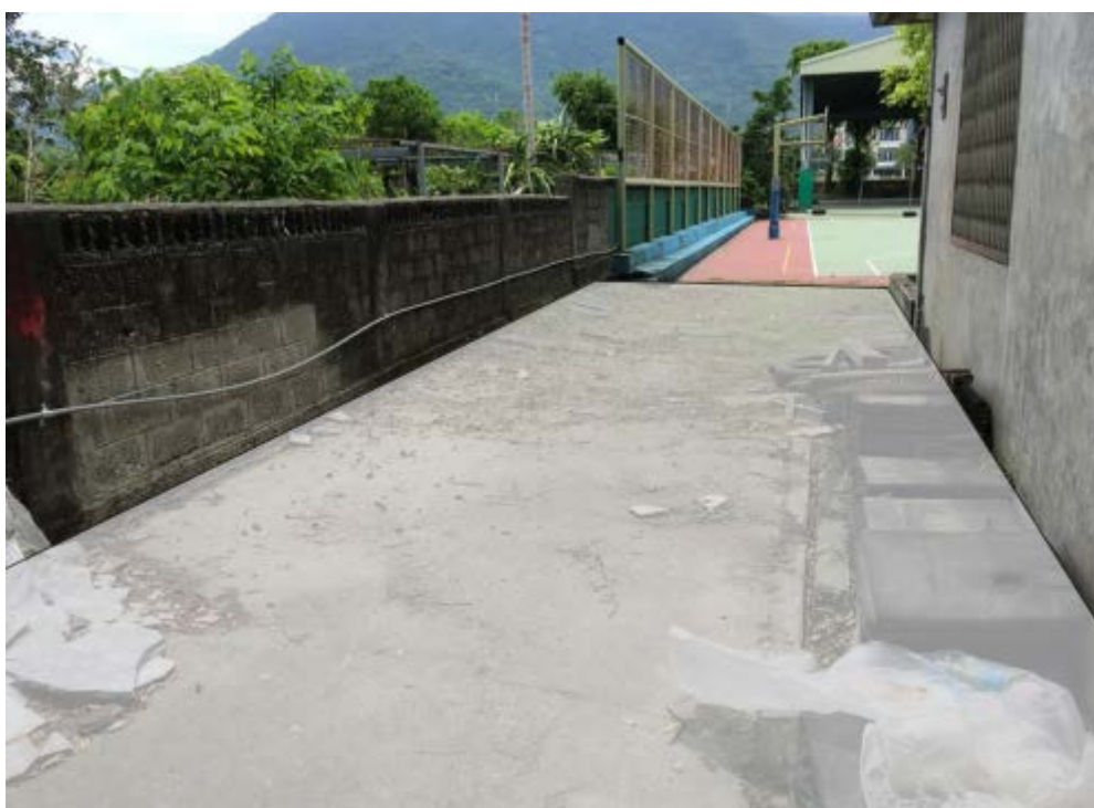
西側舊屋前後平整化
