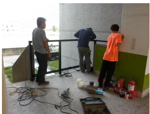
說明：施工中拆除作業
