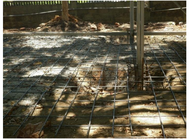
說明：鋪設地坪鋼筋
