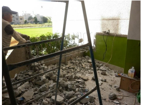
說明：野台場景施工後
