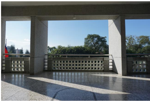
說明：穿堂走廊為磨石子地面
