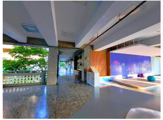
說明：拆除布告欄、書櫃，設置掛書包、衣物換鞋區及黑板區
