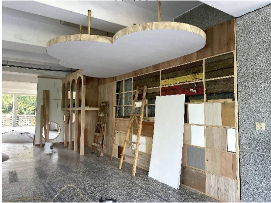
說明：天花板工程
