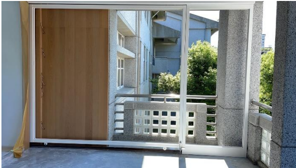
說明：燈箱牆安裝工程
