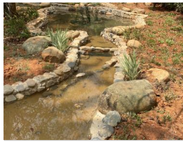
過濾構造完成
