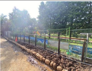
玻璃圍牆立柱完成
