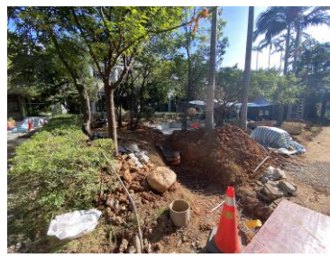
露天河道挖掘
