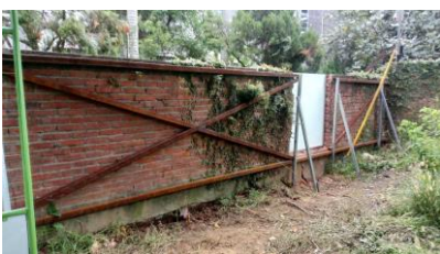
牆體鐵架補強
