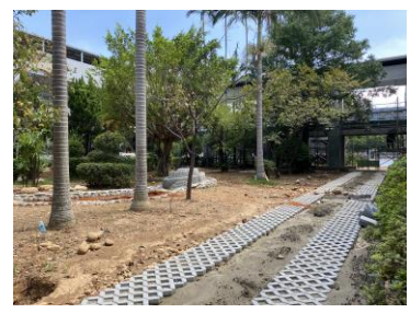
車道高壓植草磚鋪設
