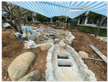
河道中水質過濾構造
