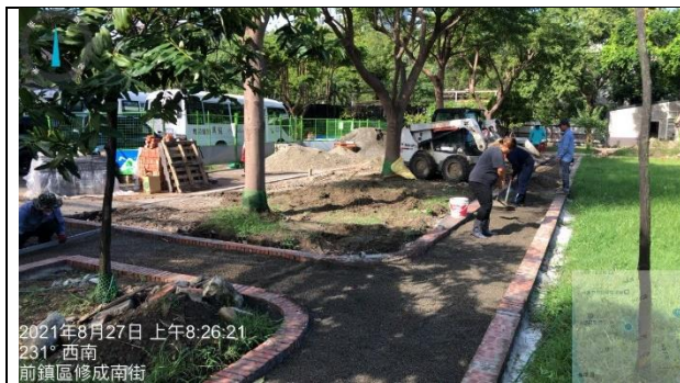
說明：鋪面襯墊層 2 分清碎石鋪設整平
