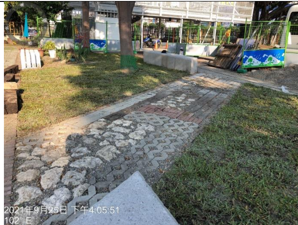
說明：樹下座椅拆模及實木座椅定位完成
