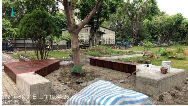
說明：樹下鋼製座椅製作
