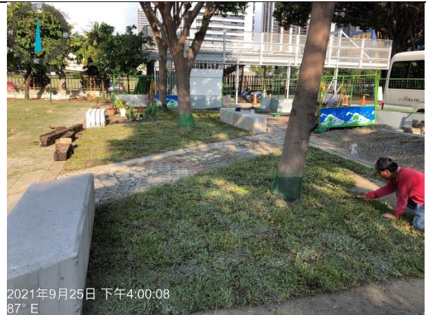
說明：複合式鋪面鋪築作業
