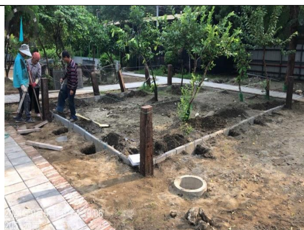
說明：圍欄立柱作業
