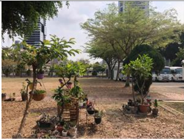
說明：烏龜的家施工前概況二
