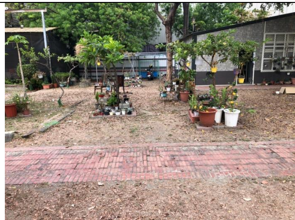
說明：烏龜的家施工前概況三
