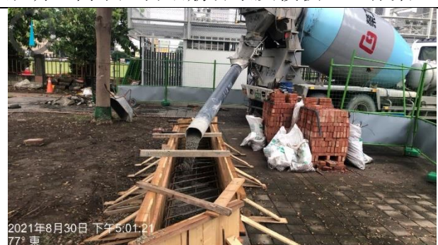
說明：樹下座椅鋼筋綁紮及模板組立作業
