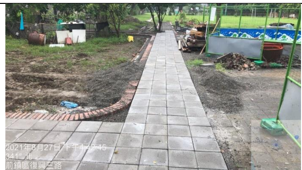
說明：平板磚鋪築作業
