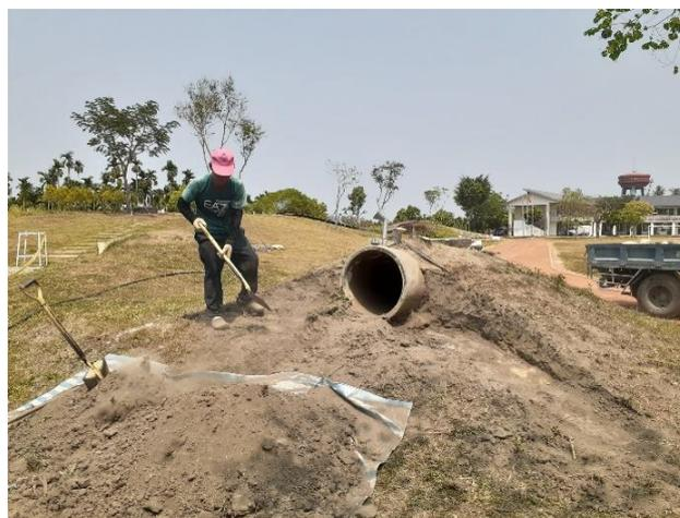
**說明：**琉璃隧道（函管）外圍用楓港石鋪設以強化其上的土石不致滑落，草皮可順利生長，並且函管出入口調整土層的高度，避免土石於下雨時分大量流入函管內。
