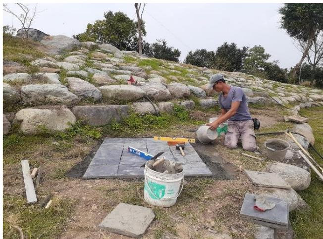
**說明：**蛇腹紋意象區的石板提高，讓它們不會輕易被週邊的雜草掩蓋，另外，石板底部以水泥固定，防止雜草根系的擠壓而破壞石板所拼接而成的蛇腹紋圖樣。
