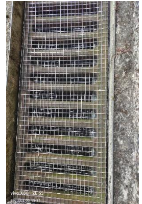
說明：驗收後建議修改部分，感謝由縣政府補助經費重新鋪設不鏽鋼鐵網
