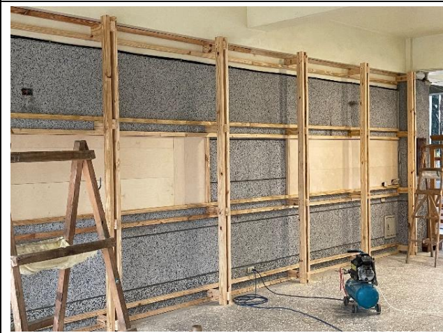
說明：中庭穿堂施工
