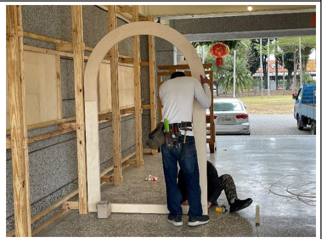
說明：中庭穿堂施工
