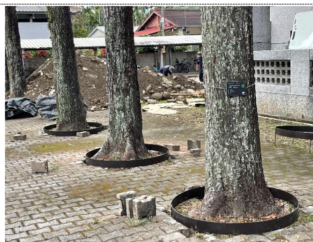
說明：樹下連鎖磚移除併訂製鐵件圍籬
