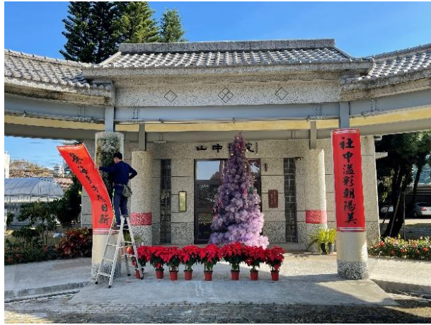
說明：拆除帆布
