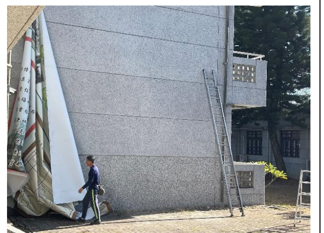
說明：拆除帆布
