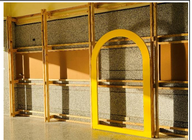
說明：中庭穿堂施工
