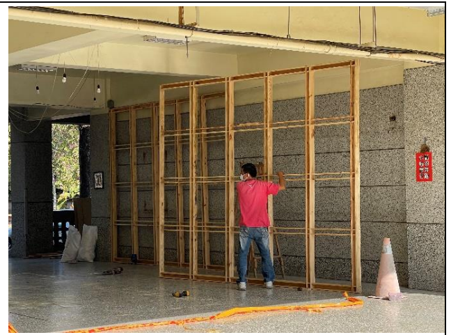
說明：中庭穿堂施工
