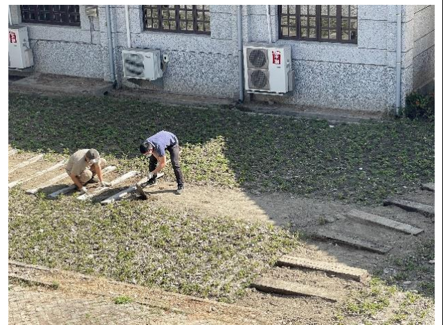
說明：鋪設枕木及石板
