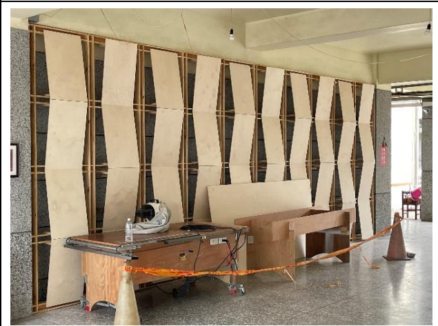
說明：中庭穿堂施工
