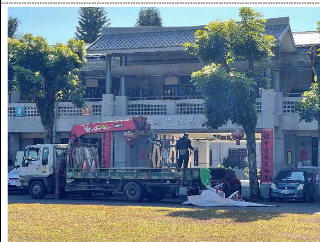
說明：拆除帆布
