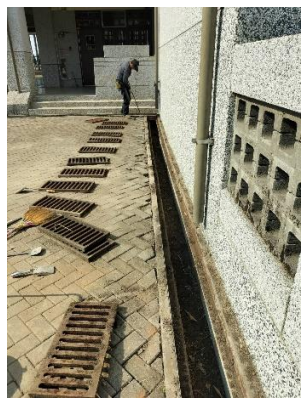
說明：驗收後建議修改部分，感謝由縣政府補助經費重新鋪設不鏽鋼鐵網
