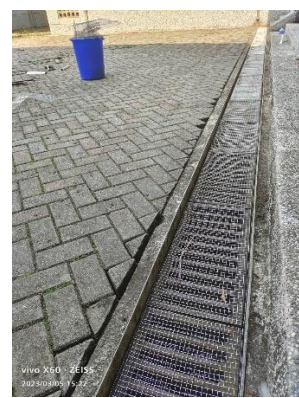
說明：驗收後建議修改部分，感謝由縣政府補助經費重新鋪設不鏽鋼鐵網
