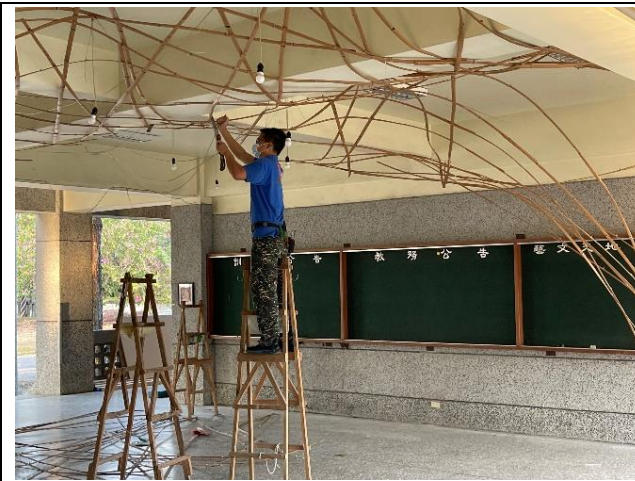
說明：拆除原先的布置
