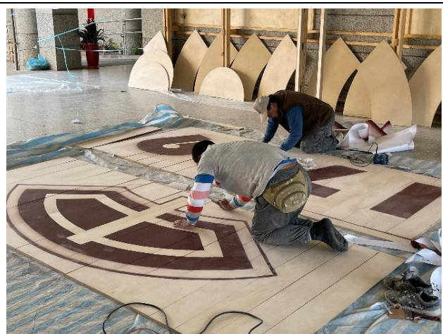
說明：門口右側造型施工
