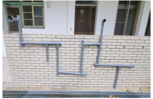
實踐現場嘗試安置（未上色）
