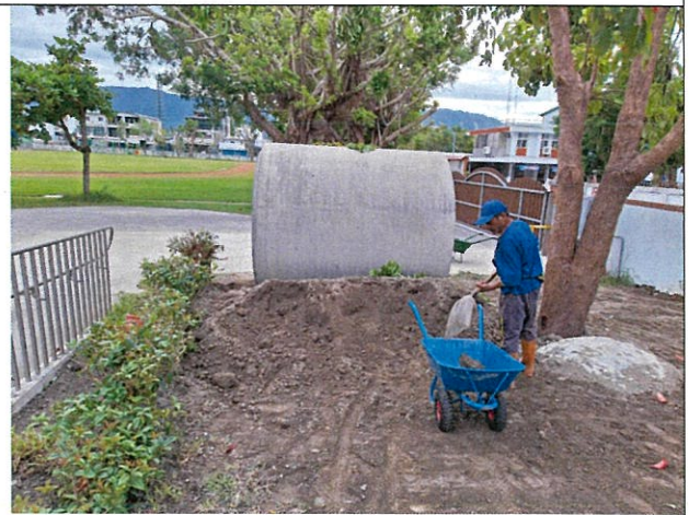
入口水泥涵管區域整地中
