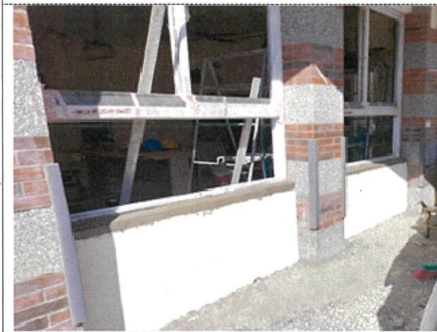
教室窗戶打除更新
