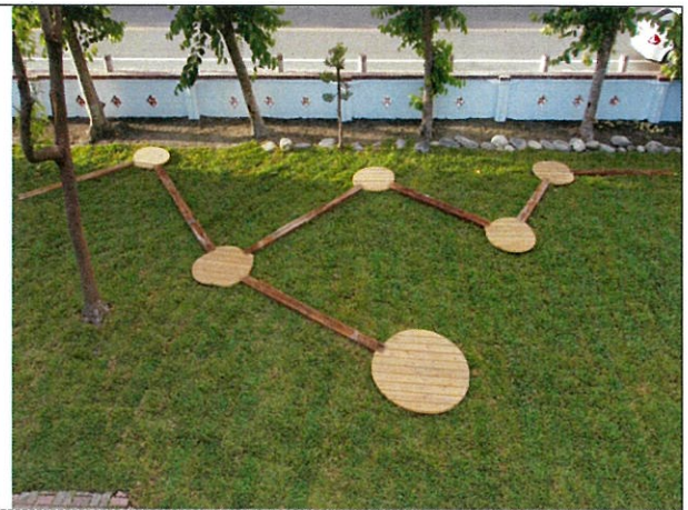
枕木平台施工完成
