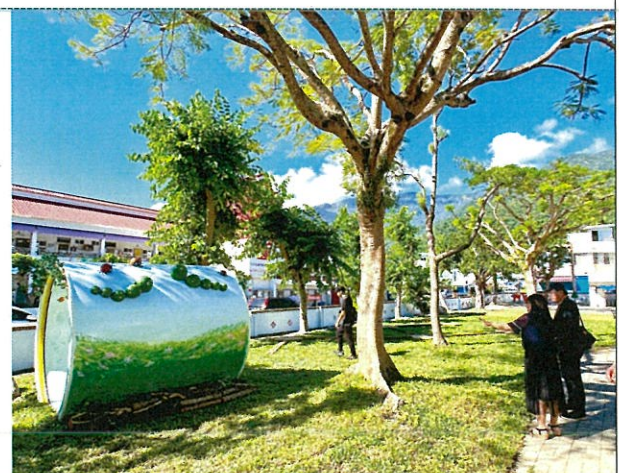
水泥涵管完工
