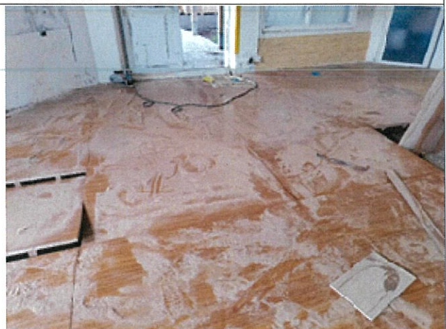
教室老舊木地板拆除
