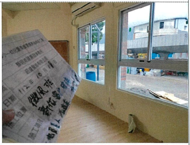
教室窗戶更新完成
