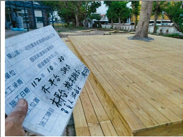
樹下木平台上透明護木漆施
