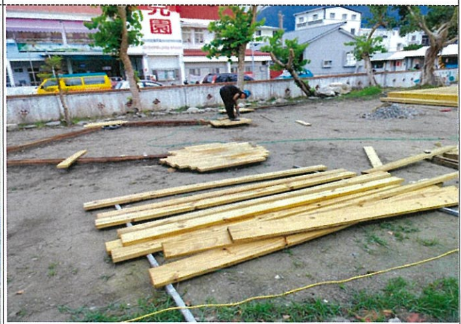
枕木平台底座施工
