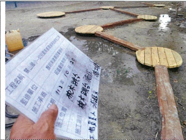
枕木平台南方松平台施工完成
