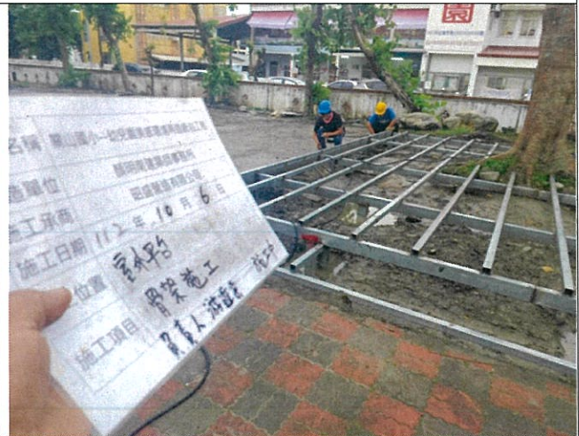
樹下木平台骨架施工
