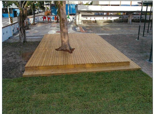
樹下木平台施工完成
