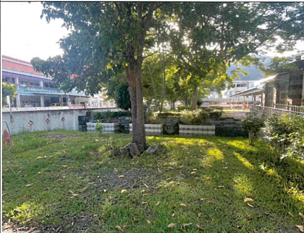
入口水泥涵管區域施工前照片
