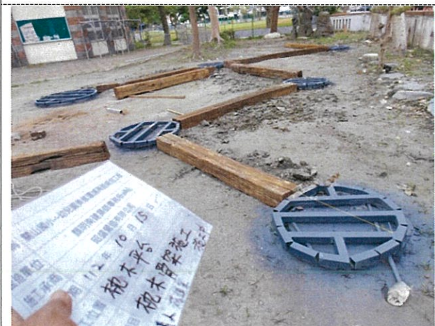
枕木平台骨架及底座施工
