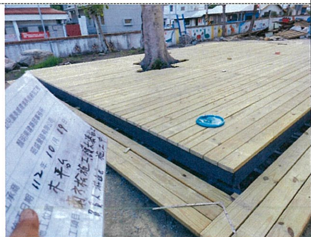
樹下木平台木料進場施工
