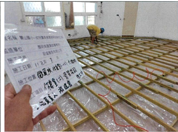
室內木地板骨架施工
