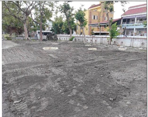
枕木平台區域整地中
