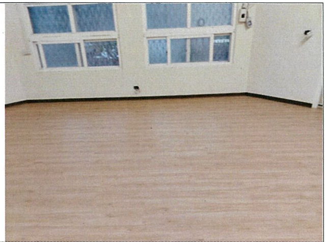
室內木地板施工完成
