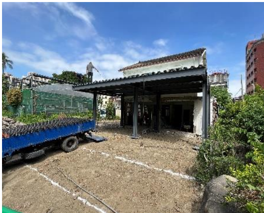
說明：鋪設屋頂
