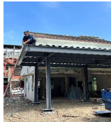
說明：焊接工程
