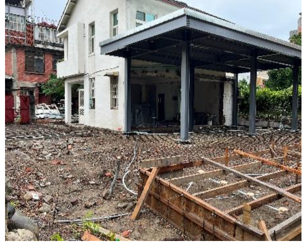
說明：預留管線
