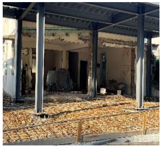
說明：室內地坪綁鋼筋
