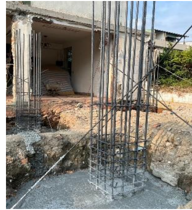
說明：立柱鋼筋
