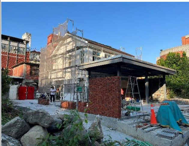
說明：鋼筋砌磚
