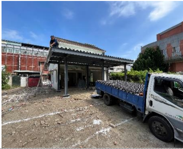
說明：焊接工程
