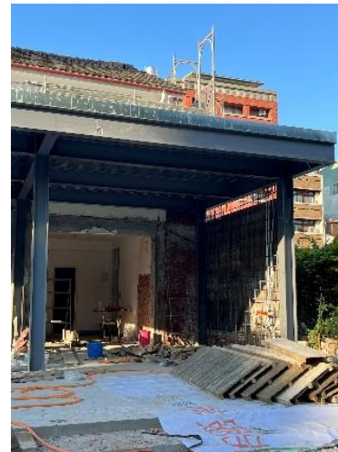
說明：壁面綁鋼筋
