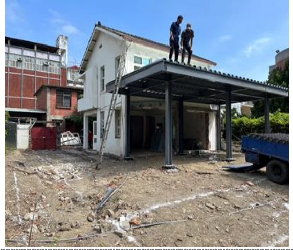
說明：檢視焊接狀況
