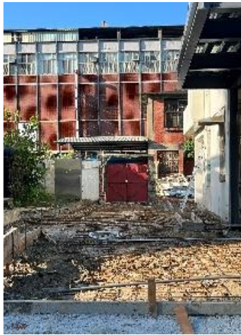
說明：戶外地坪綁鋼筋
