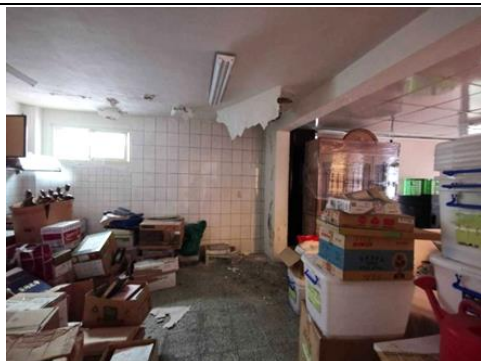
說明：施工前地磚破裂濕滑
